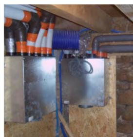
Le puits canadien est une technique ancestrale très simple qui repose sur le fait que la température du sol en profondeur ne varie pratiquement pas. En hiver, l'air frais extérieur se réchauffe avant de pénétrer à l'intérieur de l'habitation. En été, à l'inverse, l'air chaud extérieur qui circule dans la canalisation rafraîchit la maison.
